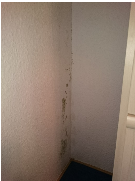
Feststellung von Schimmelschäden und Dokumentation
