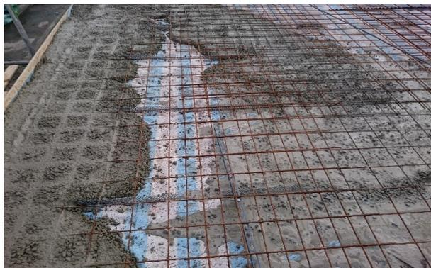
Betonieren der HBV<sup>®</sup>-Spezial Decke
